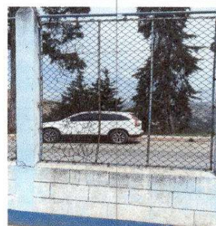
Foto 10: Reparación de tubo HG y malla galvanizada Módulo 2
