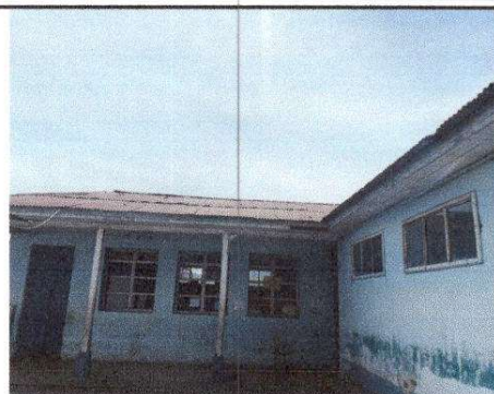
Foto 2: sustrucción de capote de lamina
