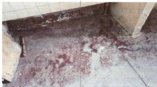
Foto 4: Sustrucción de piso de cemento liquido
