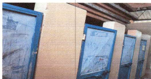
Foto 6: Mantenimiento a estructura (lijado, cambio de tubo, cepillado, sustrucciones, aplicación de pintura) a puertas servicios sanitarios Módulo 1 y 2.
