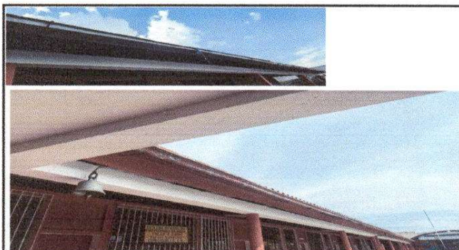
Foto 5: Sustrucción de canales de bajada de agua pluvial y sustrucción de soporte pescante de metal para canal. Módulo 1
